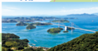
来島海峡大橋
